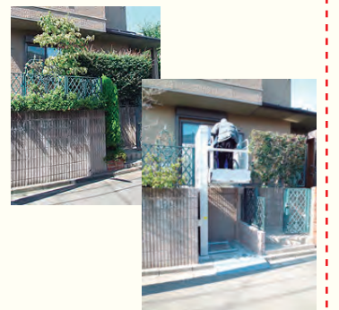
【住宅・肢体不自由・段差解消機】
