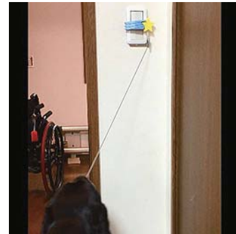
【照明スイッチの改造】
