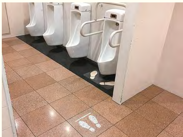
羽田空港のトイレ
