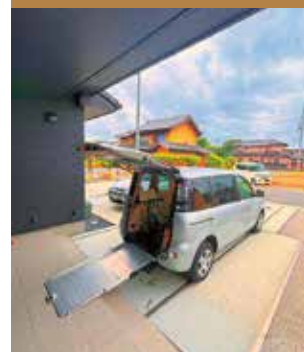
玄関ポーチと福祉車両
